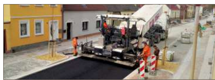
Die Oberstraße in Burg hat am Donnerstag eine Tragschicht erhalten. Der erste, rund 400 Meter lange Bauabschnitt wird damit zum Monatsende beendet. Foto: Birgit Kieß
